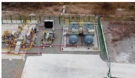
污水罐防渗及围堰
