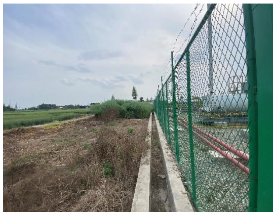
采气井场排水沟
