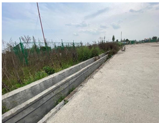
钻井井场双环沟
