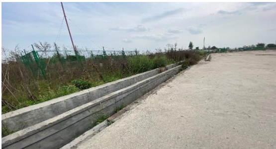
钻井井场双环沟
