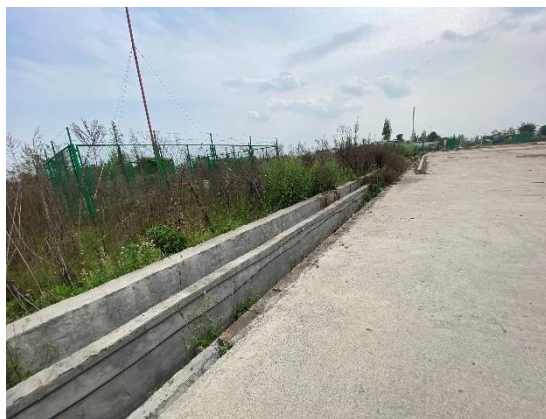
钻井井场双环沟
