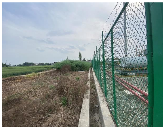
采气井场排水沟
