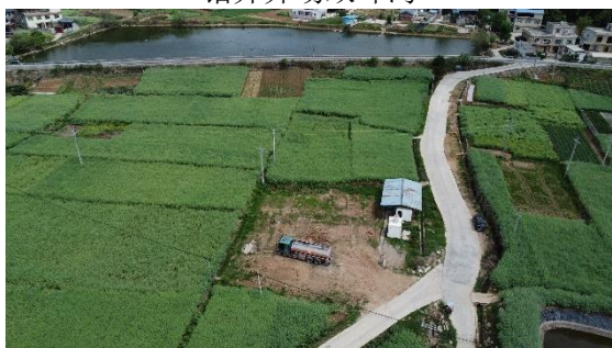
值班生活区（已拆除）
