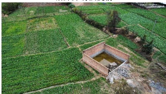
放喷池恢复前
