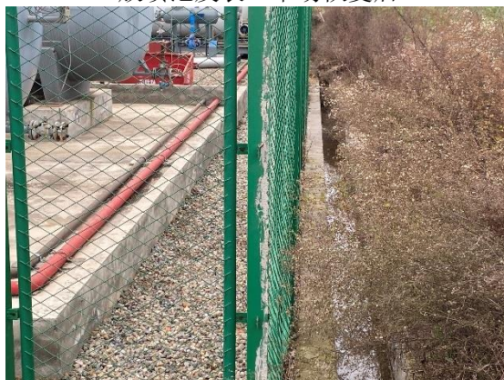
采气井场排水沟
