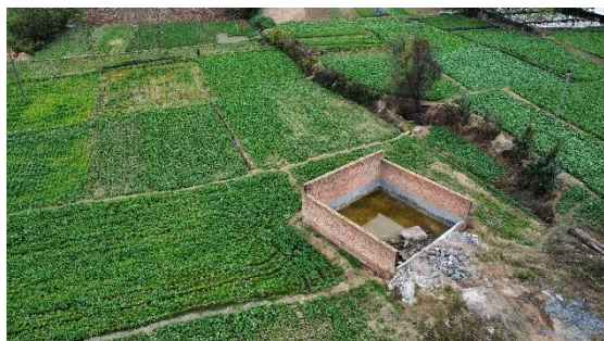
放喷池采取了重点防渗，三面围挡（已恢复）
