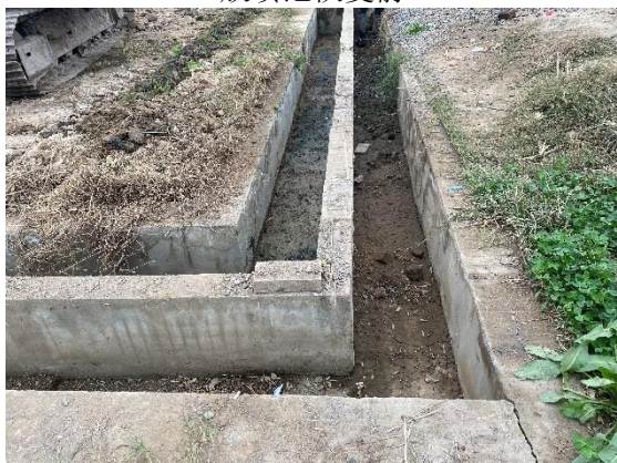
钻井井场双环沟
