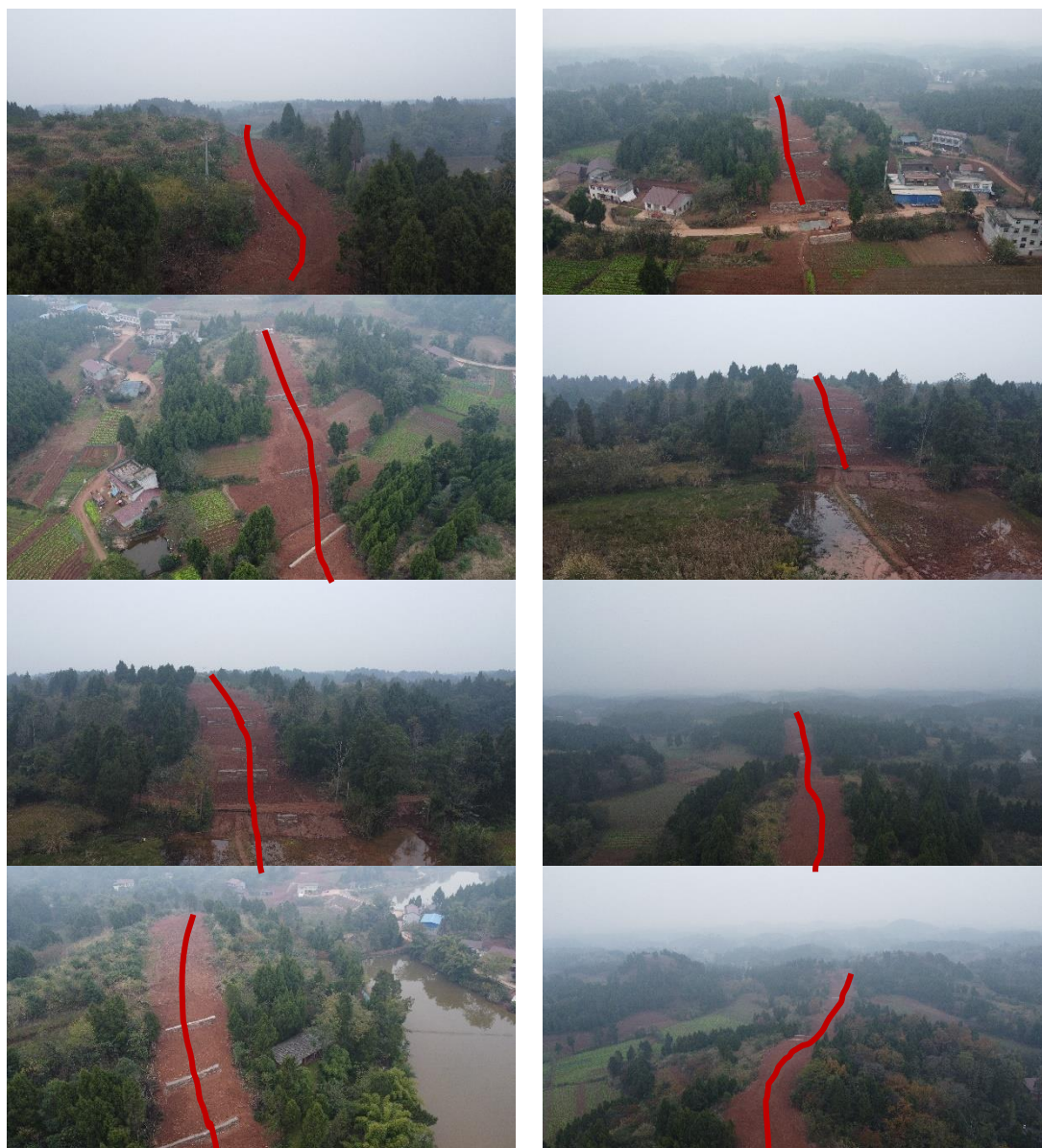
图 5.2-2 管道沿线林地穿越恢复情况
