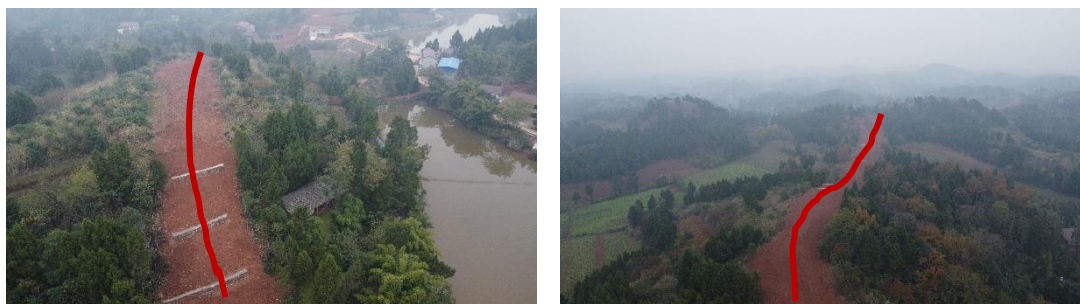
管道沿线林地穿越恢复情况
