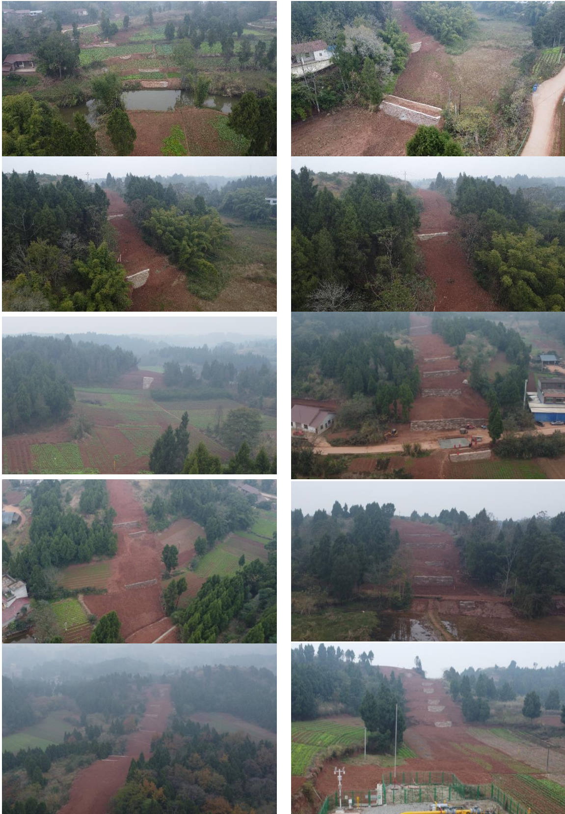
图 5.2-3 管道沿线水土保持措施情况
