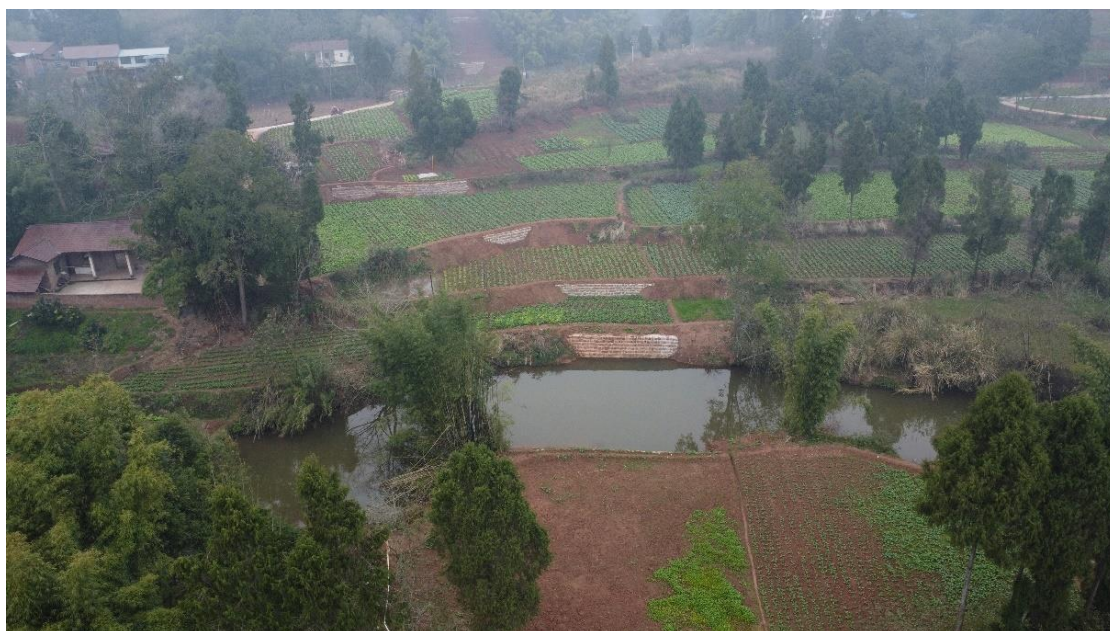
图 6.2-1 丹山河穿越恢复情况
